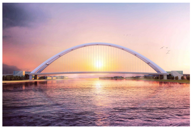
西中环快速路跨海河桥工程钢结构工程
