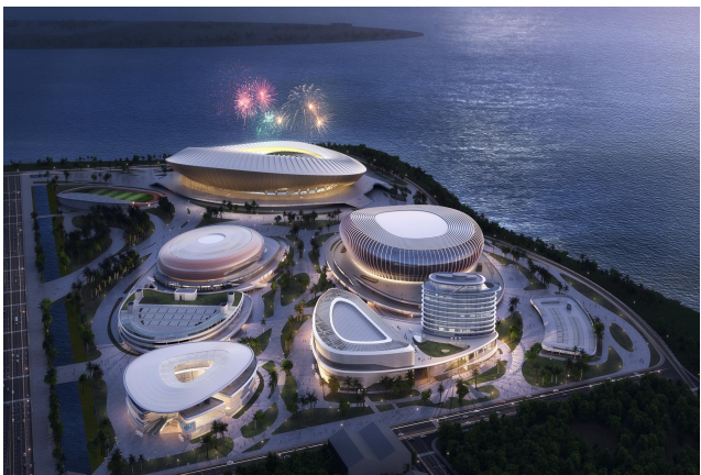
南沙全民文化体育综合体
