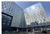
成都高新区天府软件园-储能软件公司
