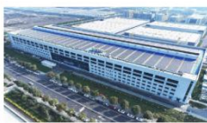
成都安泰园区—生产基地
